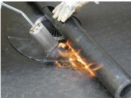
4. Zweite Bitumenlage mit Bitumenkragen des Ablaufs verbinden
