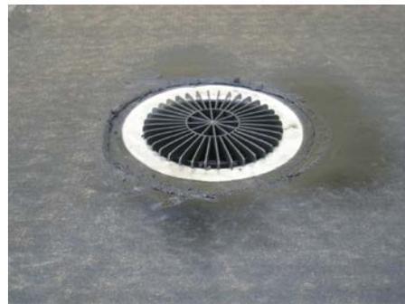
5. Fachgerechte Einbindung des Ablaufes in zweilagige Bitumenabdichtung
