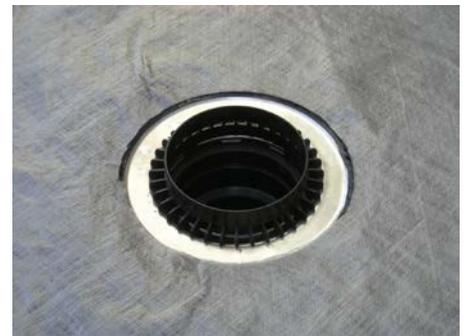
6. Bauschutz abnehmen, Trennlage auflegen, Entwässerungsring HL160 einsetzen
