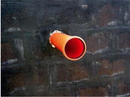
1. Rohr mit Muffenende, Wand mit Bitumenanstrich
