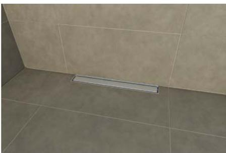
10. Bauschutz entfernen, Anschlussfugen silikonieren
