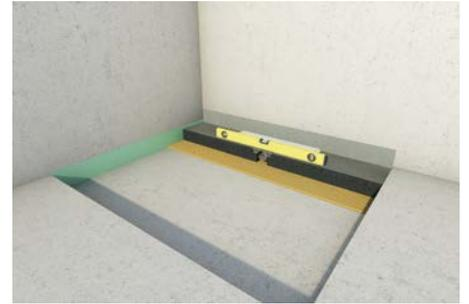
3. Duschrinne in den Klebermörtel und an die Wand setzen und waagrecht einnivellieren
