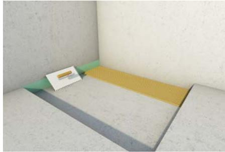
2. Vorbereitung des Untergrundes (gerade Fläche), Klebermörtel auf Untergrund auftragen
