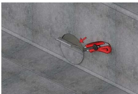
4. Bitumenbahn im Bereich der Attikaöffnung freilegen
