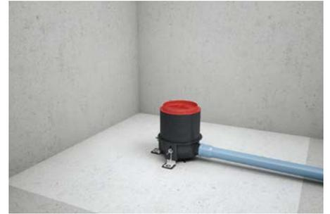
3. Ablauf einsetzen, mittels Befestigungswinkeln an der Rohdecke fixieren und mit der Ablaufleitung verbinden.
