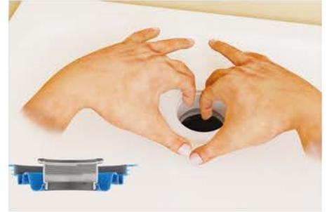
15. Den unteren Ring des Flex-Elements auf den Ventilteller aufziehen und damit Ablauf und Duschtasse dicht miteinander verbinden. Montageschlüssel/ Bauschutz in die Ablauföffnung einsetzen. Anschließend: Dichtheitsprobe!
