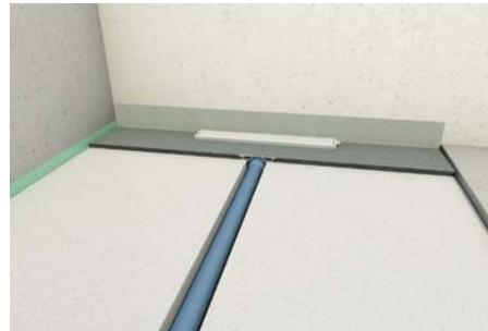
5. Trittschall- und Wärmedämmung einlegen
