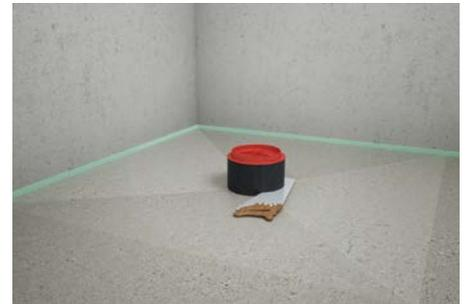
6. Nach dem Aushärten des Estrichs den herausstehenden Rohrstutzen estrichbündig mit einer Säge abschneiden.
