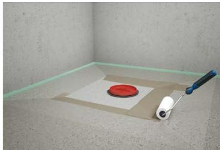
8. Feuchtigkeitsabdichtung im gesamten Duschbereich sowie unter und ober der Dichtmanschette auftragen (Sandwichverfahren), alle Anschlussstellen mit bauseitigen Dichtbändern versehen.
