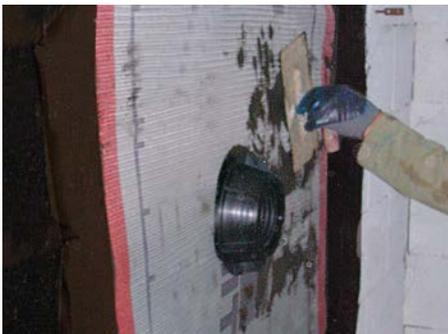
1. HL800/160 am Bauwerk fixieren und in die Bauwerksabdichtung einbinden
