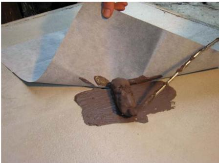
7. Verbundabdichtung vollflächig unter die Folie auftragen
