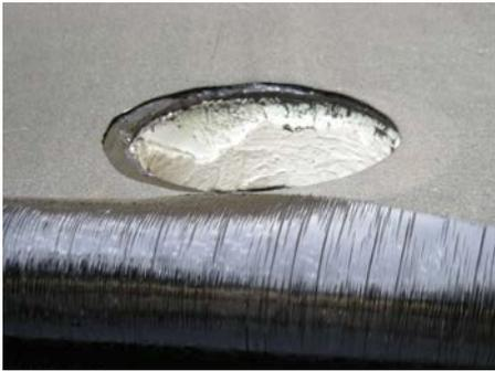
1. Kernbohrung erstellen mit Ø 300 mm, Voranstrich auftragen, erste Bitumenlage auflegen
