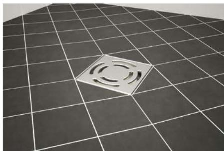
11. Bauschutz abnehmen und Edelstahlrost einsetzen.
